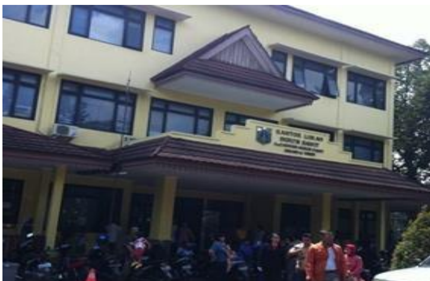
Gambar 2. Gedung Kelurahan Duren Sawit
